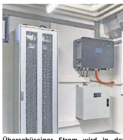
Überschüssiger Strom wird in der hausinternen Batterie gespeichert.
